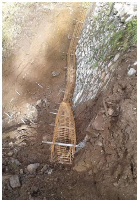
Aufwändige Sicherungsmaßnahmen Zufahrtsweg und Stützmauer „Znach“
